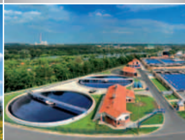
Lewobrzeżna Oczyszczalnia Ścieków w Poznaniu
